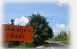
ติดตั้งป้ายเตือนก่อนถึงพื้นที่ก่อสร้าง
