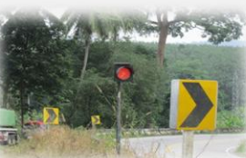
ติดตั้งสัญญาณไฟกะพริบ
