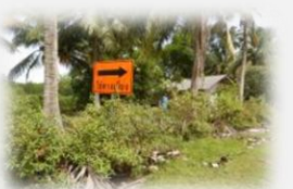
ติดตั้งป้ายทางเบี่ยง
