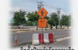
ติดตั้งป้ายจำกัดความเร็วไม่เกิน 40 กม./ชม.
